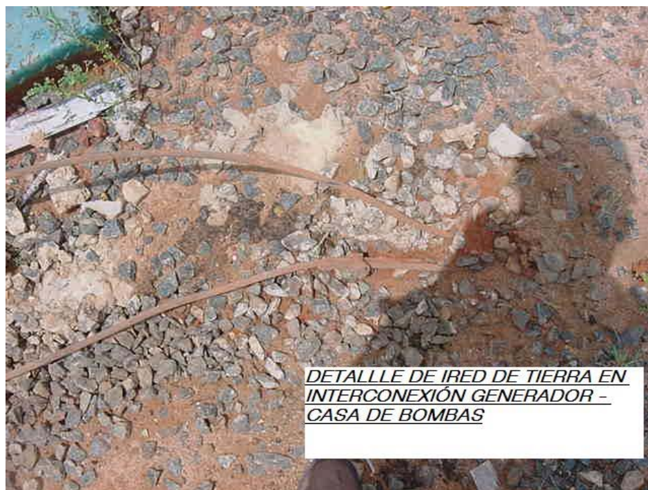
Fig. 6.12 – Detalle de Red de Tierra
